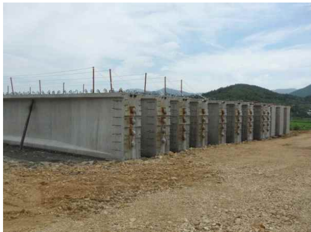
IPC Girder 임시보관전경
